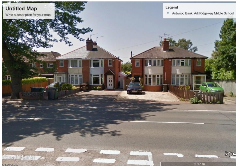
Nos 1348 Evesham Rd
