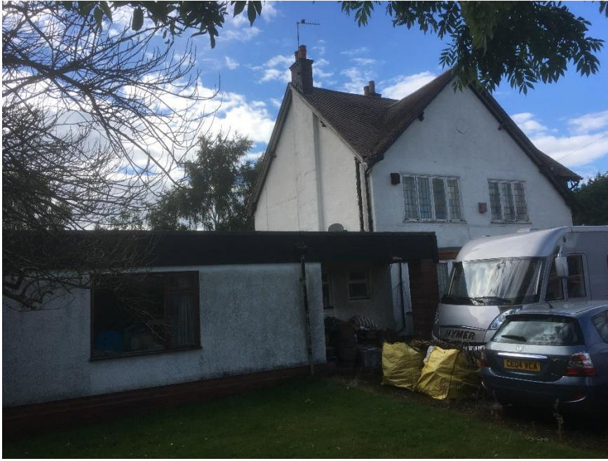
Nos 1344 Evesham Rd
